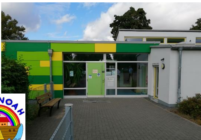
Neubau-Zugang für 3 Gruppen
